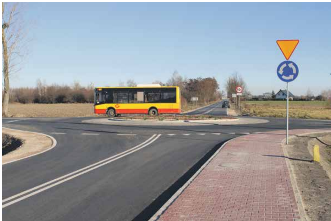
Ukończone rondo w Cegłowie.
