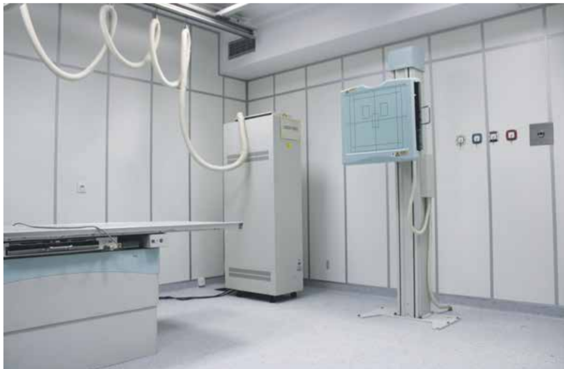
SOR w Szpitalu Zachodnim podczas remontu.
